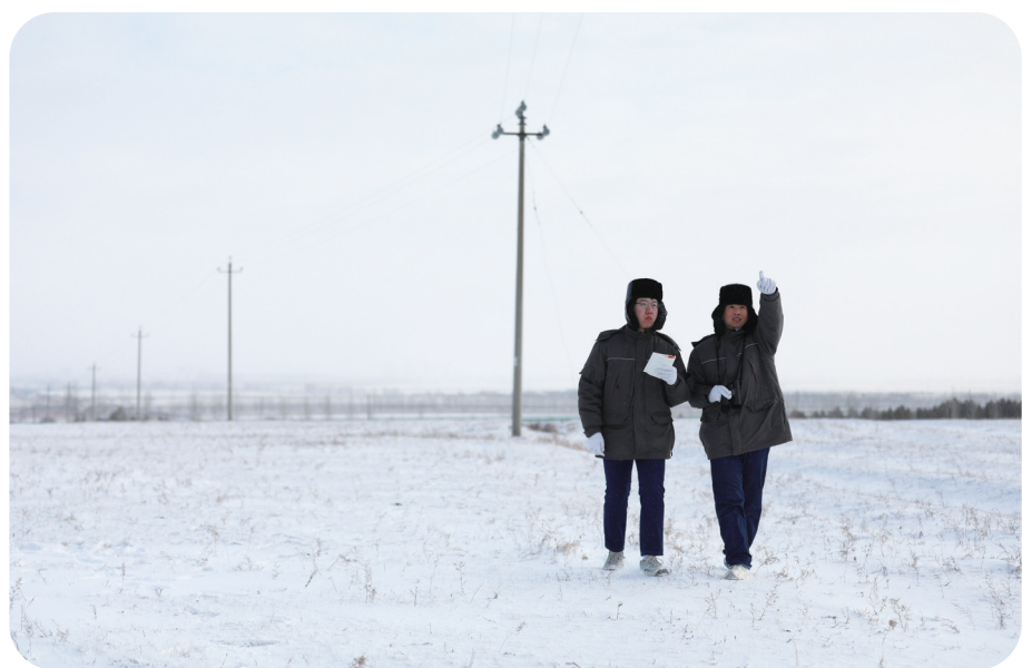
11月26日,国网呼伦贝尔供电公司10kV索朝一线进行巡视,确保降雪天气供电安全。 张长禹/摄
