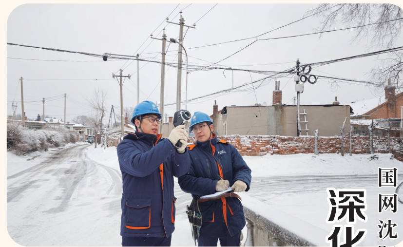
11月26日,国网沈阳供电公司高坎供电所网格服务人员,在仁境村同步开展线路特巡和用电检查服务等工作,全力保障乡村百姓用电采暖。 杜岩/摄
