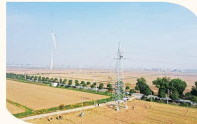
图为国网九江彭泽县供电公司施工人员在风棉35千伏线路工程10号至11号塔开展跨越施工。
