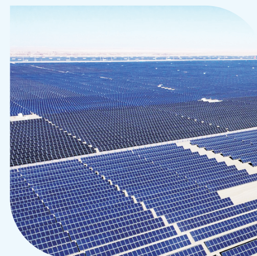
图为青海海西1格勒木太阳能发电场。王国旗/摄
