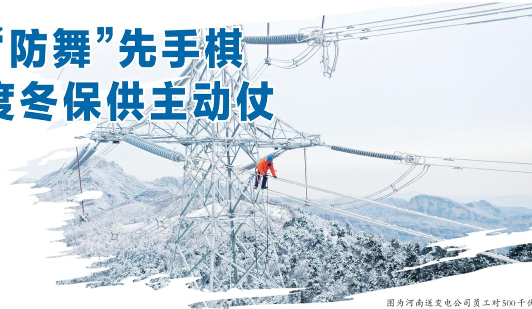
图为河南送变电公司员工对500千伏汉郑线进行人工除冰作业。夏然/摄
