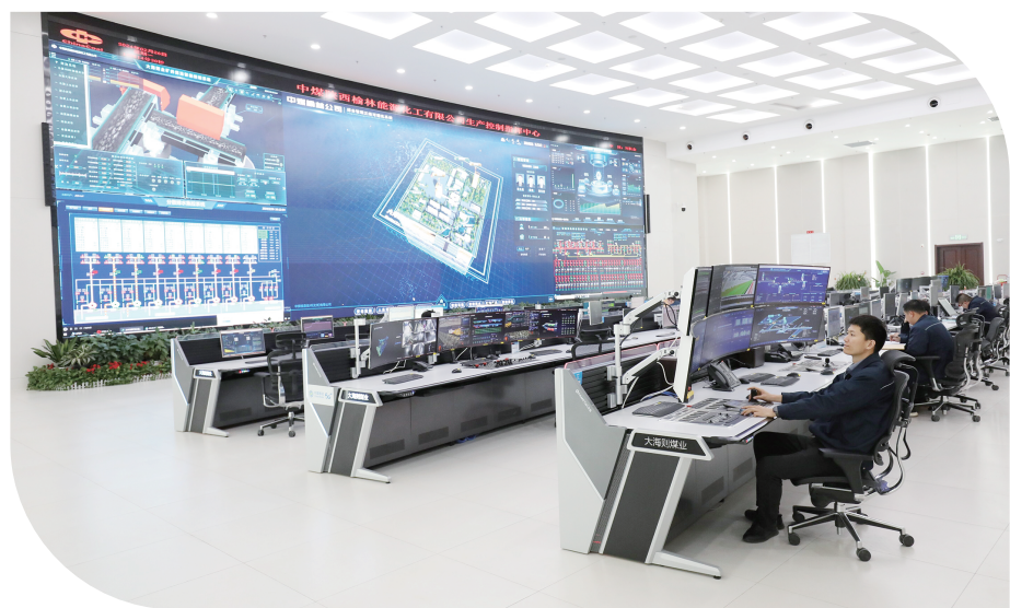
煤矿生产控制指挥中心
