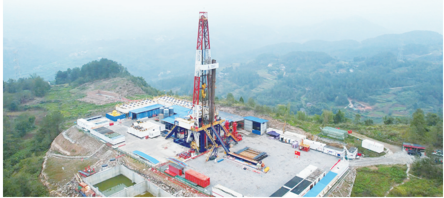
通南巴气田钻井现场。中国石化/供图
