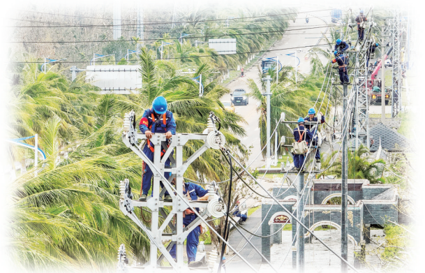
9月9日，贵州电网遵义供电局支援海南抗击台风抢修复电党员突击队在文昌市龙楼镇航天小学旁，紧急抢修受灾线路，全力保障学校复课用电需求。李杰志 梁军/摄
