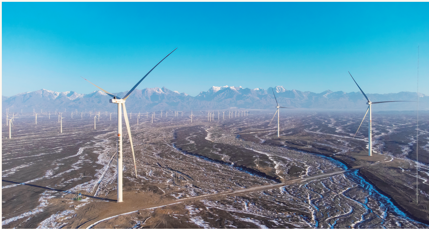
龙源达坂城风场位于乌鲁木齐达坂城戈壁滩上，安装10台三一重能5兆瓦风电机组，2022年1月实现全容量并网发电，为天山南北源源不断输送绿色电能。张娟/摄
