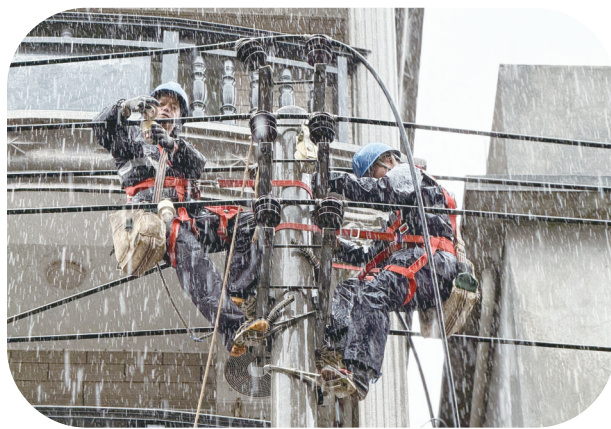
国网福建电力抗台风“康妮”抢险队准点到位,在风雨中为福州长乐10千伏前塘线断线抢修复电。 吴小云/摄
