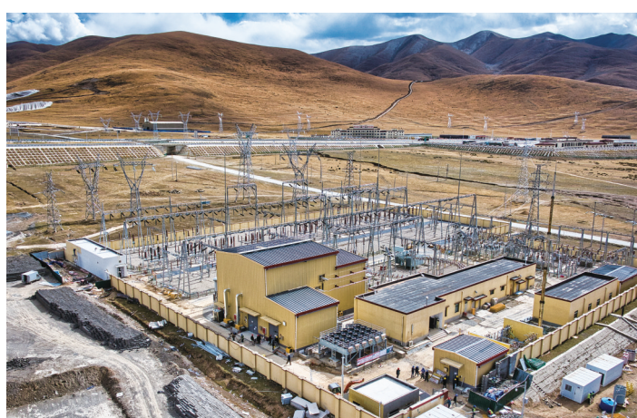
全国首套电网侧带超容构网型SVG外景(当雄站)。
