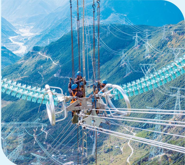
10月18日，四川省甘孜州泸定县二郎山上的川渝1000千伏特高压交流输电工程施工现场，电力工人在高空开展导线收紧作业。田海/摄
