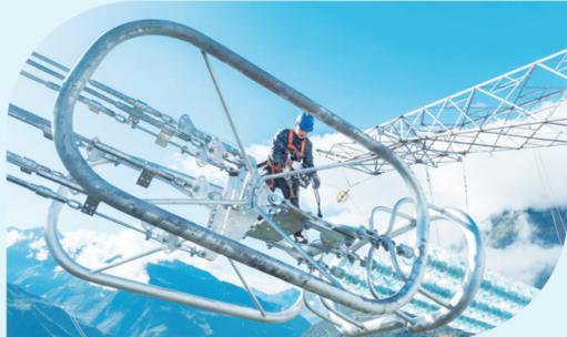
10月17日，四川省甘孜州泸定县的川渝1000千伏特高压交流输电工程施工现场，电力工人在高空开展放线作业。曹颀/摄
