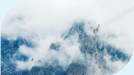
10月19日，四川省甘孜州康定市小天都水电站附近的川渝1000千伏特高压交流输电工程施工现场，电力工人在高空开展间隔棒安装作业。田海/摄
