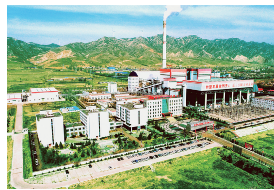
图为晋控王坪发电公司全球首个采用空冷机组低位能分级混合加热供暖技术的煤电机组。
