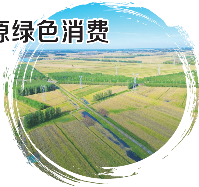
图为建设中的辽宁康平电厂—蒲河500千伏线路,该工程投运后可促进沈阳地区风能资源的开发利用。邹新警/摄
