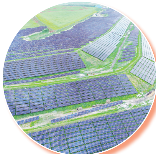
图为白音华自备电厂可再生能源替代工程300MW光伏项目。该项目为全国最大露天矿排土场光伏项目,位于国家电投白音华露天矿排土场区域。
