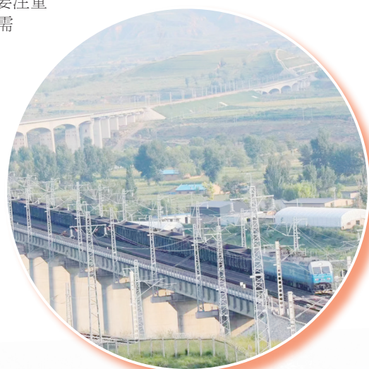
图为浩吉铁路一段。该铁路是世界上一次性建成并开通运营里程最长的重载铁路,也是国家“北煤南运”重要的运输通道。
