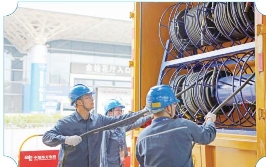
9月21日,南方电网广西电网公司保供电应急发电车和工作人员提前抵达展馆会场外,完成电源接入、调试等工作。邓有雄/摄
