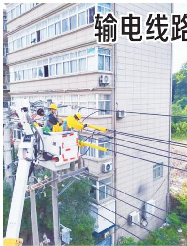
8月21日，国网德安县供电公司员工正在带电更换鑫城纺织支线#01杆隔离刀闸。 罗鹏/摄
