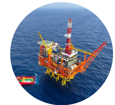
图为亚洲第一深水导管架平台“海基二号”。中国海油/供图
