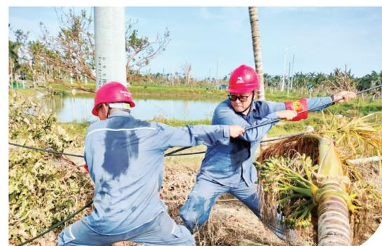
9月14日,南方电网云南楚雄供电局援琼抢修人员在海南省文昌市潭牛镇10千伏青山线家属队3号公变台区开展低压抢修复电工作。云南电网公司/供图
