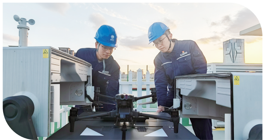
国网莆田供电公司员工正在检查无人机机巢设备。
