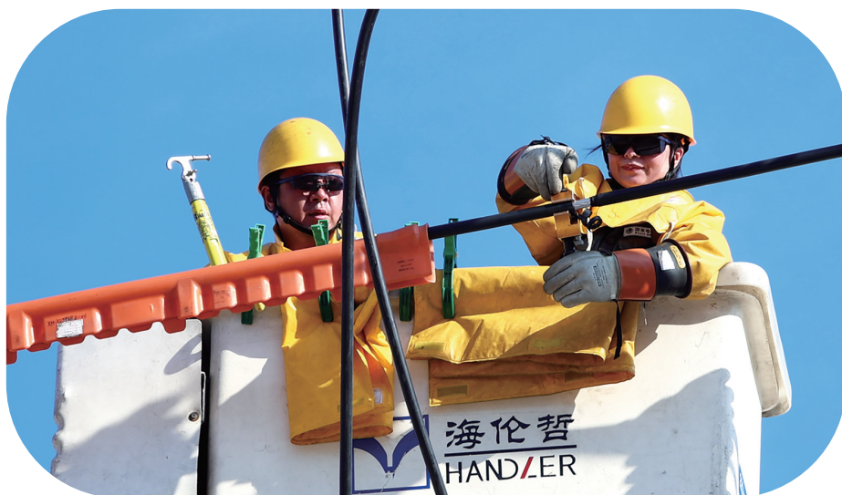
图为8月28日，国网娄底供电公司员工曾启明(右)和杨勇(左)在10千伏曹向线8号杆开展带电搭火作业。刘青/摄
