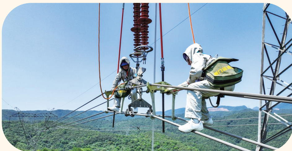
图为8月22日，在湖北省当阳市，国网湖北超高压公司运维人员等电位更换500千伏龙斗一回26号塔发热合成绝缘子，消除线路缺陷，保障三峡水电外送通道安全稳定运行。陈军/摄
