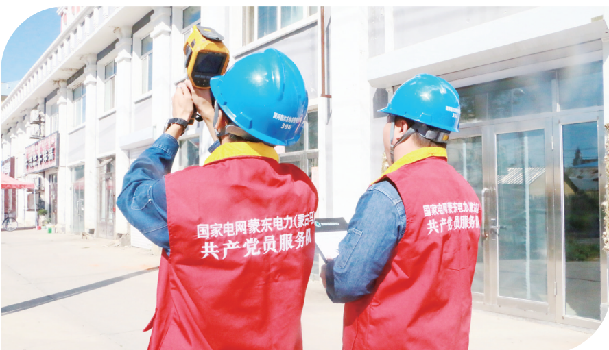
8月30日,国网额尔古纳市供电公司组织员工对供暖相关线路进行巡视 贺馨怡/摄
