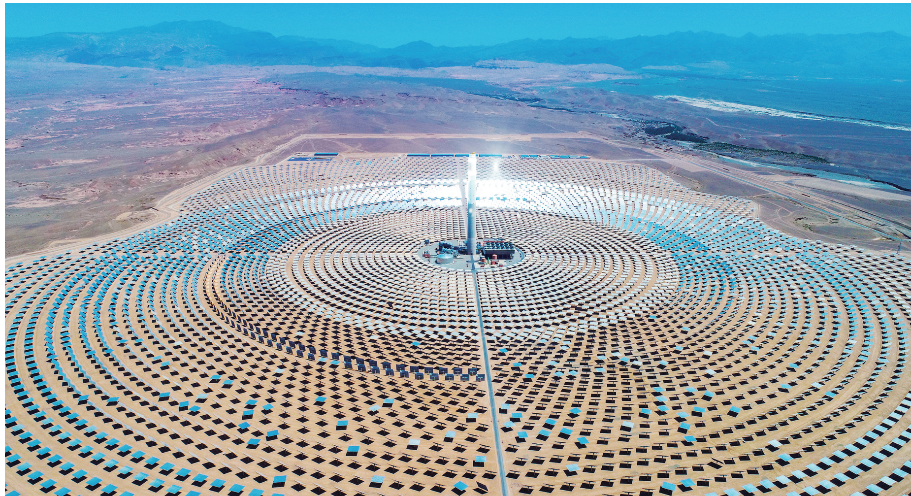
图为由中国能建参与设计、建设的摩洛哥努奥三期150兆瓦光热电站项目。中国能建/供图
