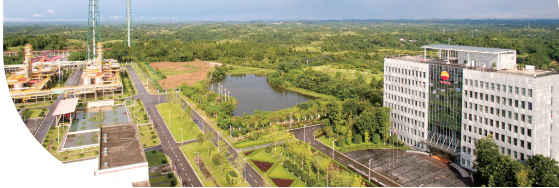
图为遂宁净化公司厂区。中国石油西南油气田公司/供图
