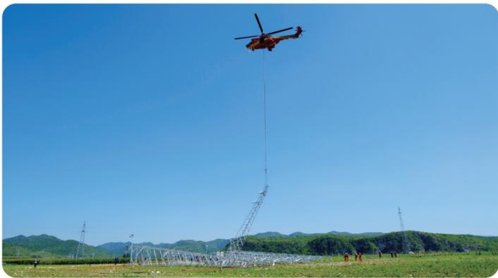
8月27日，国网辽宁电力联合国网空间技术公司，使用直升机从材料站吊起66千伏朱家线31号新塔。 牟超/摄
