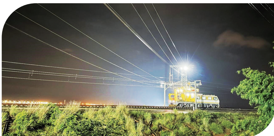
图为国铁昆明局提供平台作业车配合线路拆除工作。云南电网/供图
