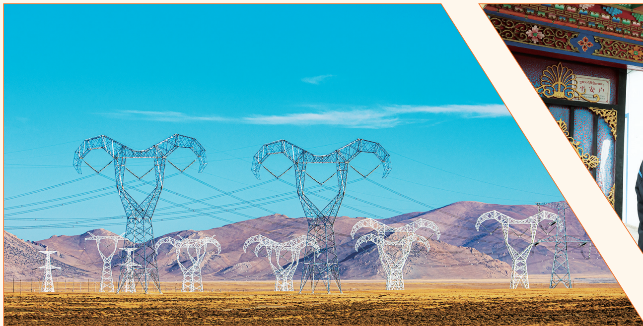
图为阿里联网线路工程。
