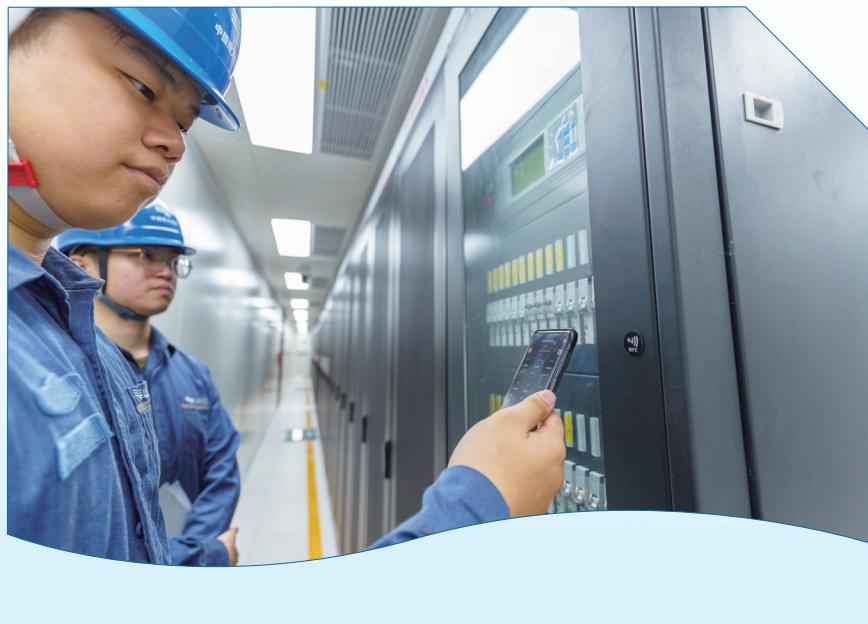
▲南方电网深圳供电局基于开源鸿蒙自主研发通信机房数智运维系统,提高了机房智能管理水平。图为供电人员使用鸿蒙手机“碰一碰”机房设备,就能掌握该设备实时数据。黄海鹏/摄
