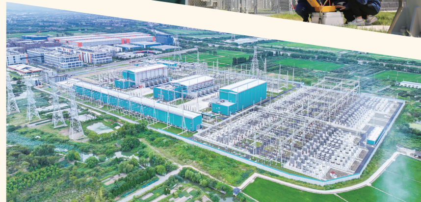
▲ 图为±800千伏钱塘江换流站俯瞰图。吴米佳/摄
