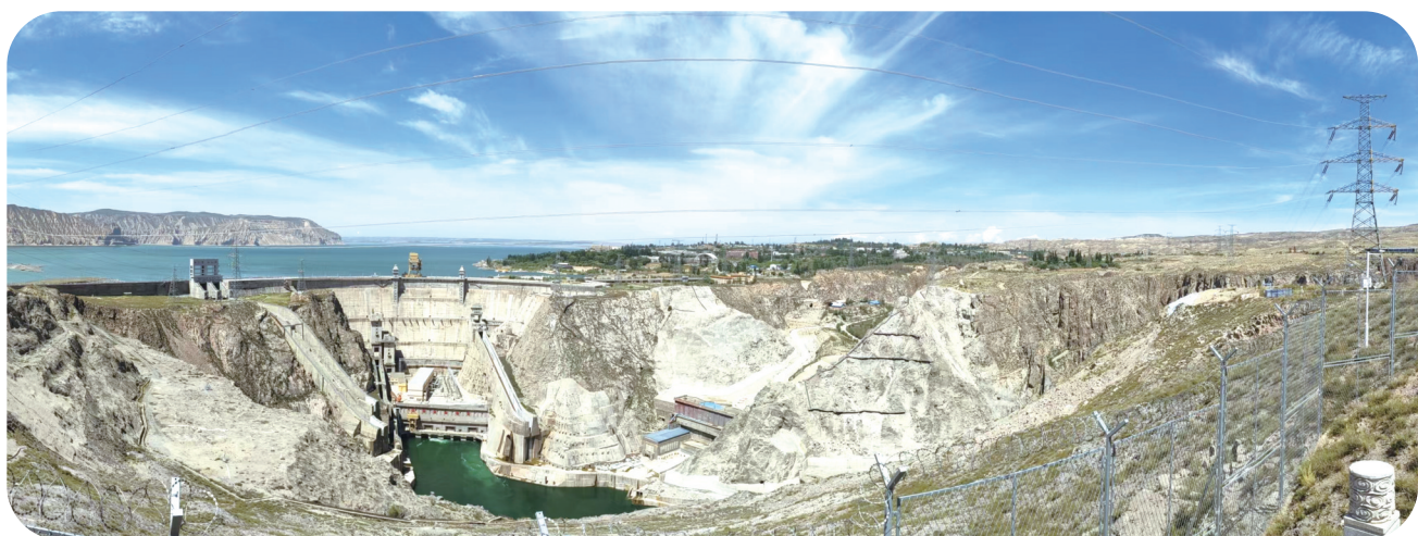
图为黄河上游“龙头”电站——龙羊峡水电站。朱学蕊/摄
