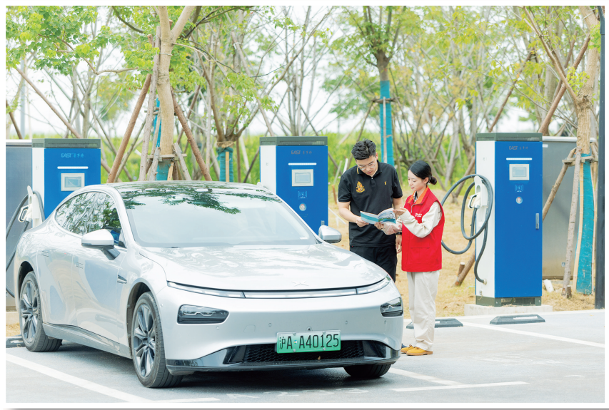
电力员工在上海天文馆停车场开展新能源车充电桩安装志愿服务。
