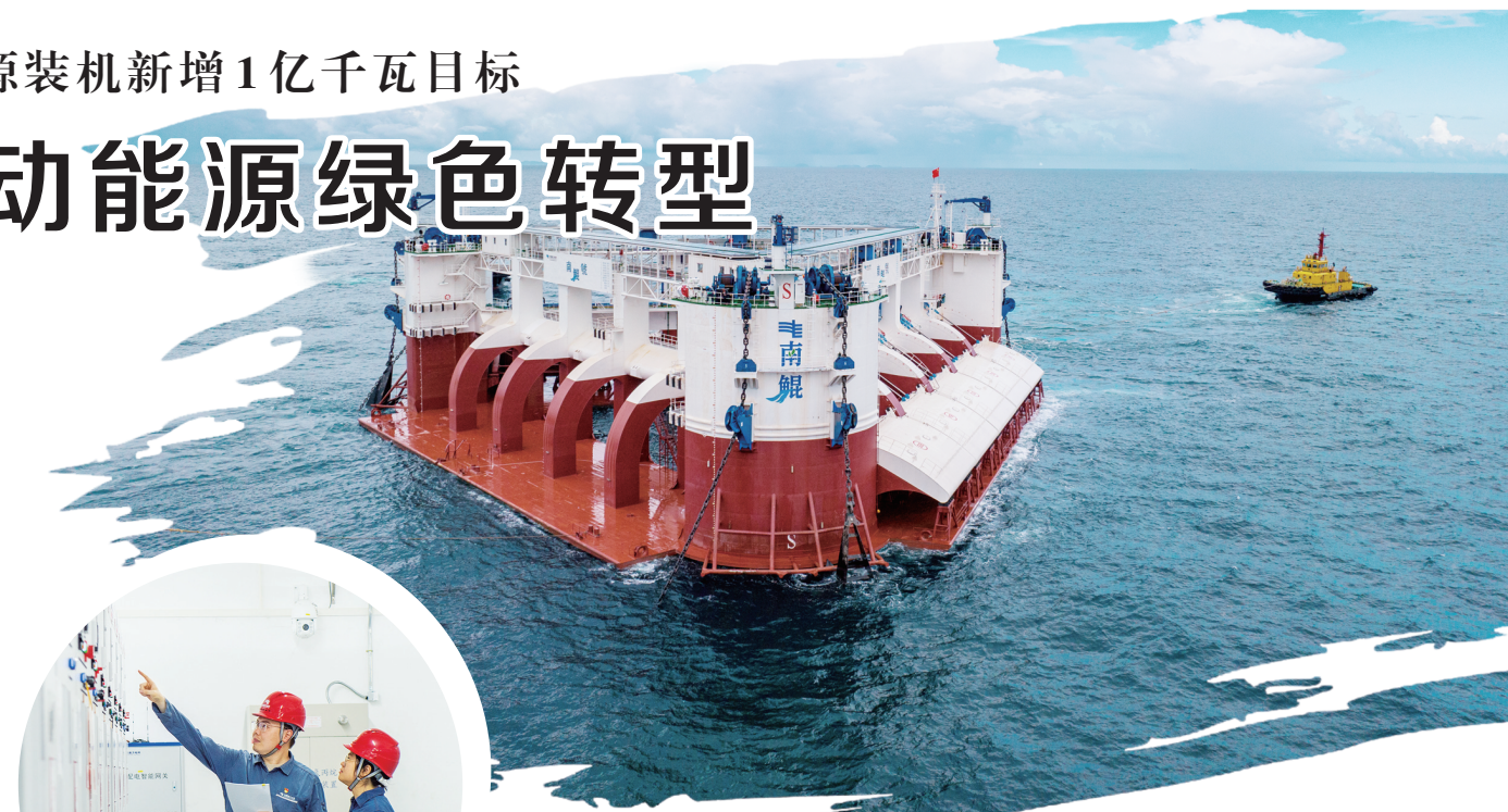
图为世界首台兆瓦级漂浮式波浪能发电装置“南鲲”号,日发电量相当于3500户家庭1天的用电量。南方电网/供图
