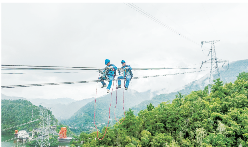
7月30日,南方电网云南送变电公司普洱版纳运检站工作人员对500千伏漫昆Ⅱ回线进行检修作业。张强/摄
