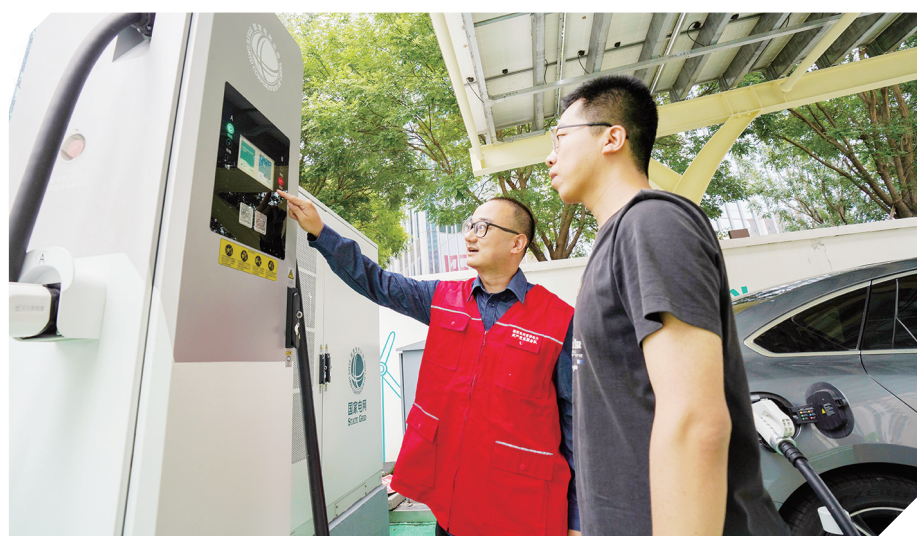
图为国家电网首都电力(丰台)共产党员服务队队员在丰台区东管头超充站为车主介绍超充桩使用和安全充电常识。张涛/摄
