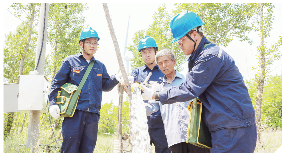
图为国网彰武县供电公司四合城供电所员工为治沙村民侯贵维修水泵,协助浇灌树苗。艾勇/摄
