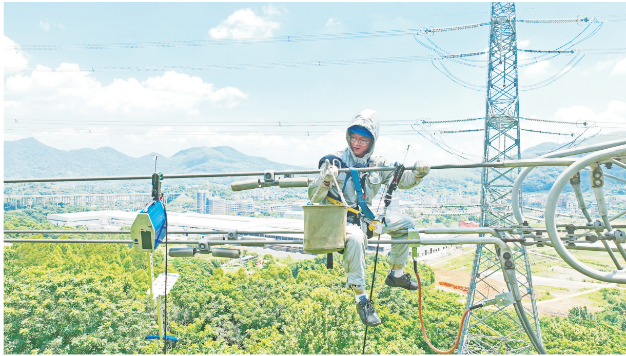
图为国网福州供电公司员工在500千伏东大Ⅱ线带电处理引流板发热隐患。国网福建电力/供图
