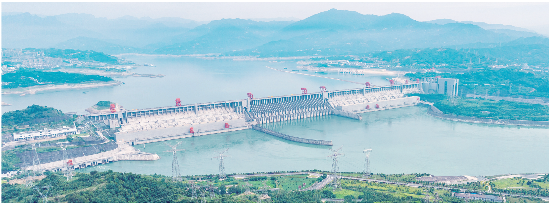
世界最大清洁能源走廊由乌东德、白鹤滩、溪洛渡、向家坝、三峡、葛洲坝6座梯级水电站沿江干流自上而下排列构成,总装机容量7169.5万千瓦,全部110台机组今年首次全开运行,助力迎峰度夏。图为湖北宜昌三峡电站外送输电线路。 人民图片
