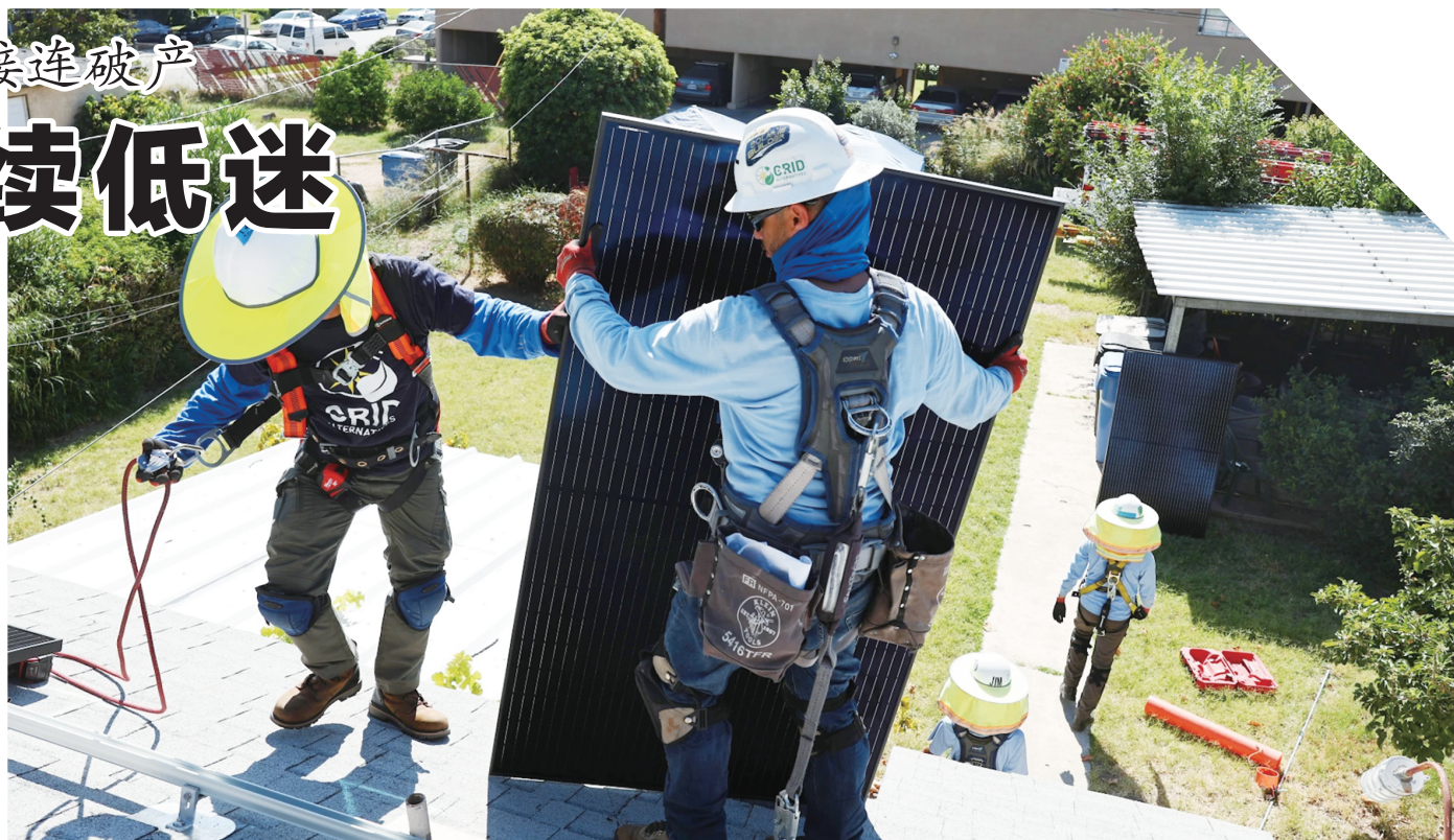
美国加利福尼亚州匹茨堡市的一座住宅正在安装光伏发电系统。
