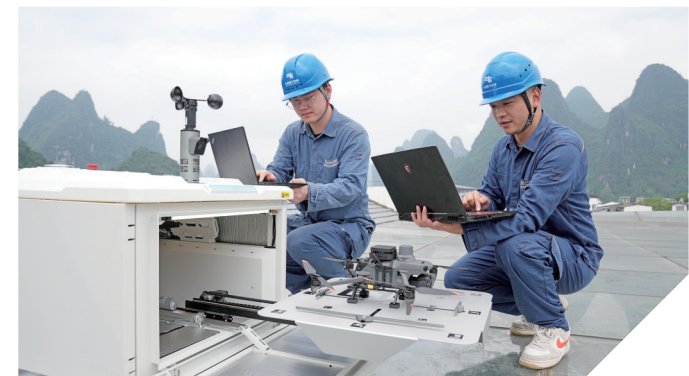
南方电网广西电网公司完成10千伏大源线2套无线充电无人机和机巢的安装、调试,并对线路进行了试飞巡检。马华斌/摄
