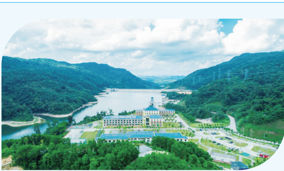
图为海南琼中抽水蓄能电站。
