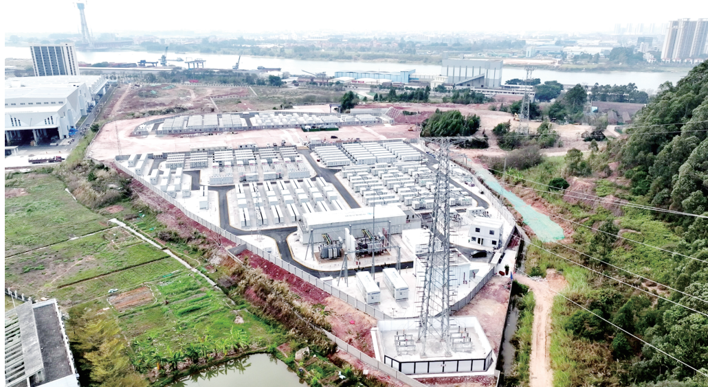
2024年1月3日，粤港澳大湾区最大新型储能电站——宝塘储能站，在广东佛山正式投运。
