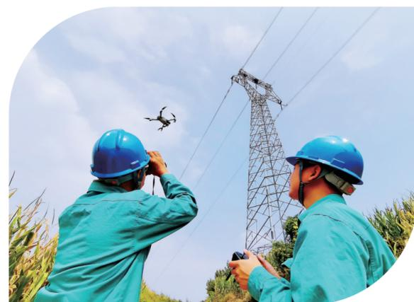
图为在山西临汾220千伏壶古线72号铁塔旁,国网临汾供电公司输电运维人员用无人机对输电线路进行巡视。
