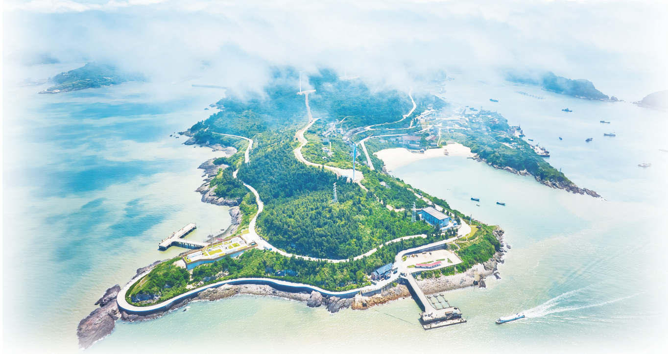
图为浙江台州大陈岛氢能综合利用示范工程一隅。人民图片
