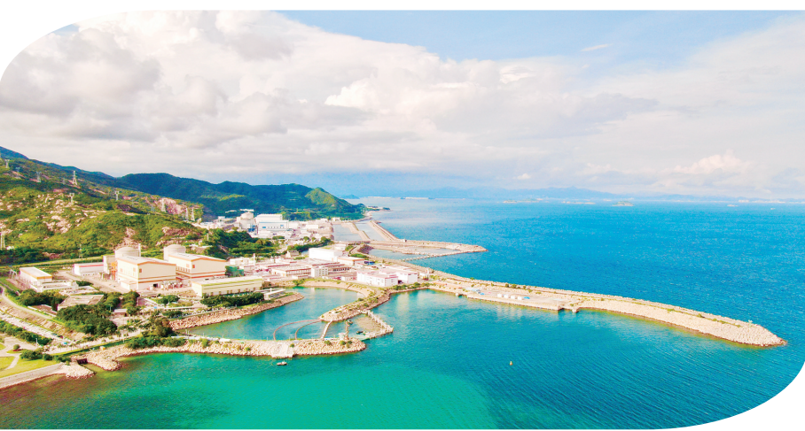
图为大亚湾核电基地。大亚湾核电/供图
