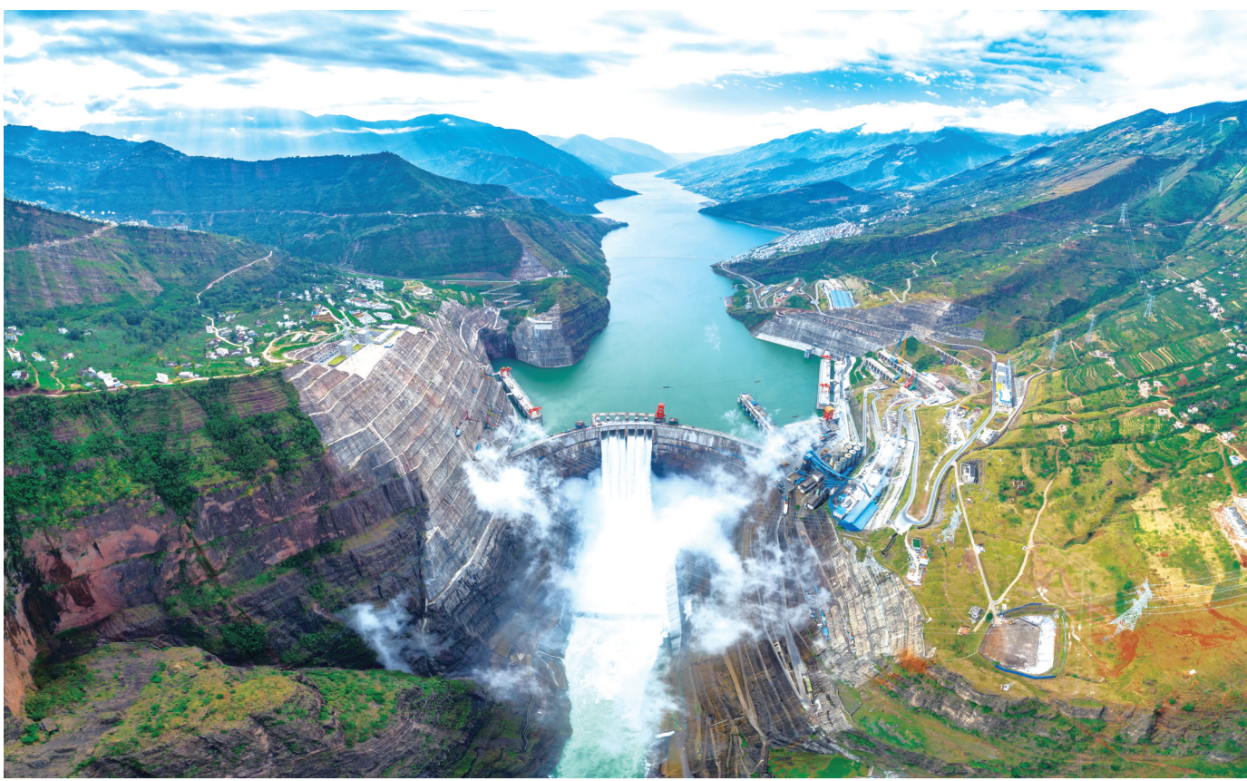
装机规模全球第二大的白鹤滩水电站。
