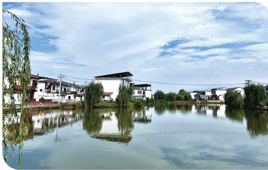
周坊村河两岸的房子上都安装了光伏,是户用屋顶光伏项目连片建设的典型区域。
