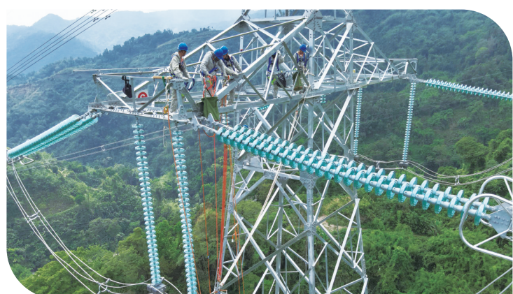
云南电网公司输电分公司联合德宏供电局在德宏盈江,通过采用“V形布置滑轮组+吊篮”等电位作业法带电将500千伏太平德宏线018号塔C相引流线串线串改造为双跳线串作业。 叶丽娟/摄
