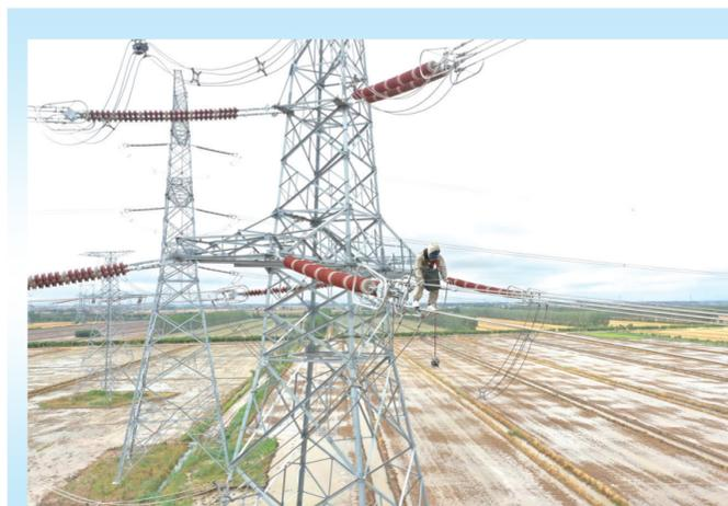
图为在江苏省连云港市连云区500千伏田圩线66号塔，国网江苏超高压公司协同国网江苏连云港公司创新开展“无人机+小飞人”带电作业，及时处理跳线引流板发热，为迎峰度夏期间江苏500千伏输电动脉安全运行提供坚实保障。
