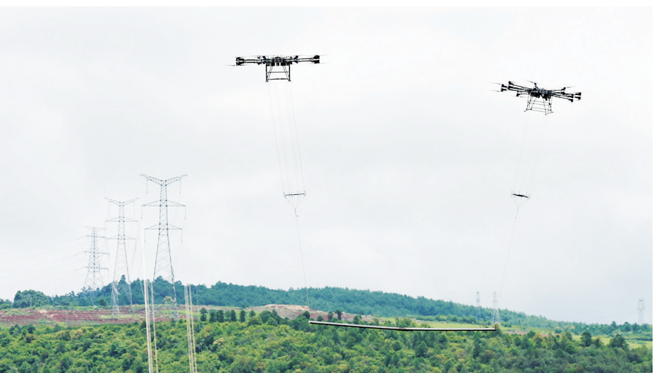
两台重载无人机联合吊运电力物资。
