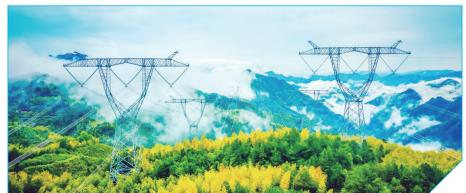
图为景宁畲族自治县域浙北一福州1000千伏特高压交流输变电工程线路。
