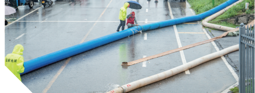
图为6月25日,国网衡阳供电公司支援团队与国网长沙县供电公司“电雷锋”对长沙县梨花园台区开展排渍抢险工作。邓倩/摄
