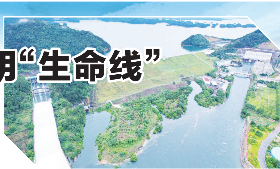
图为国网江西柘林水电厂第一溢洪道三孔闸门全开泄洪,并保持机组满发。高原/摄
