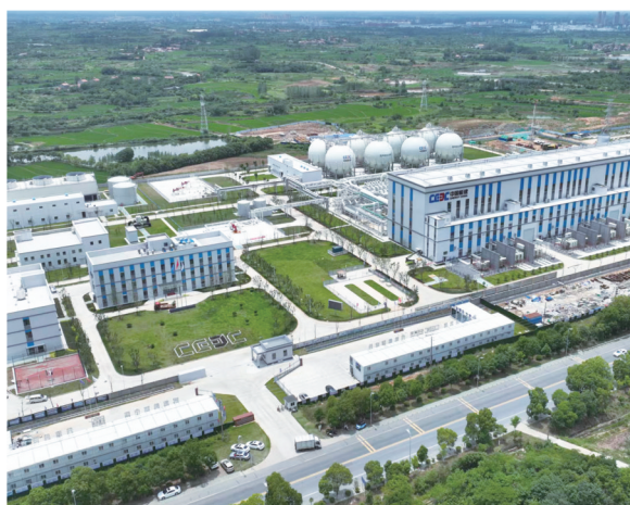
世界首台(套)湖北应城300MW压缩空气储能示范工程。
