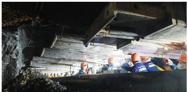
杨村煤矿的薄煤层开采工作面
