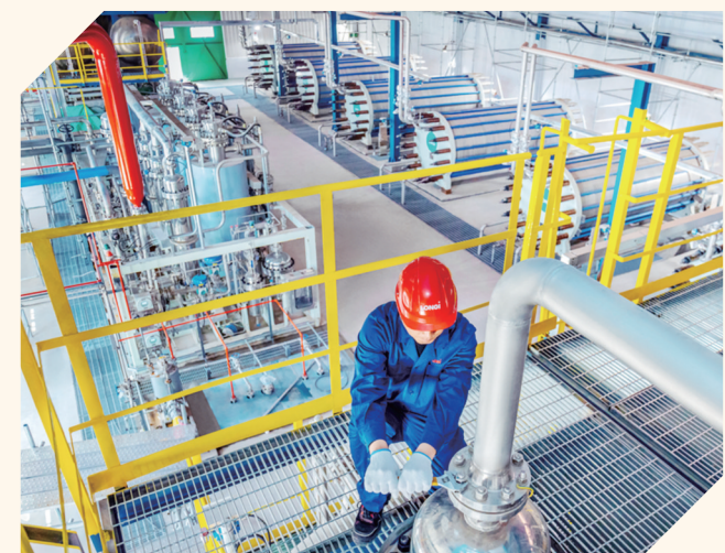
中国石化绿氢示范项目现场 隆基氢能/供图
