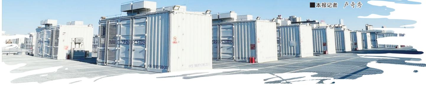
图为大连恒流储能电站变流升压设备。南瑞继保/供图
